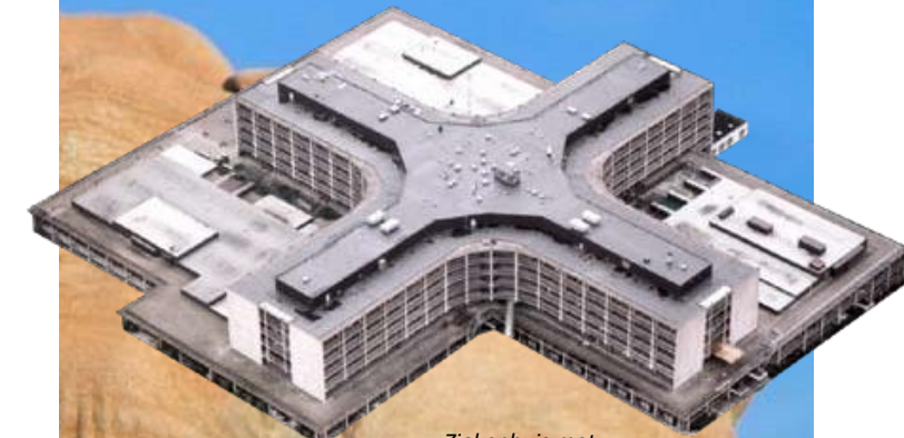
Ziekenhuis met mechanisch bevestigd daksysteem
